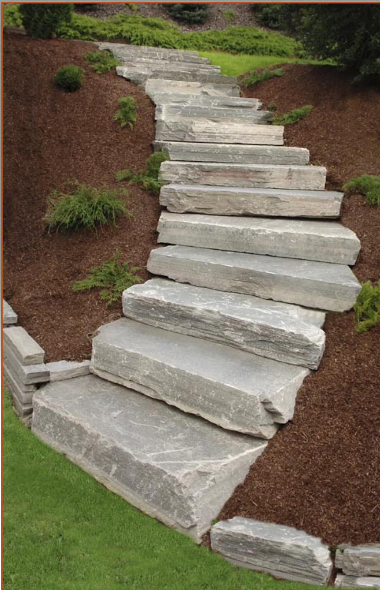
Terrengtrinn i Oppdalskifer. De tynneste øverst og de tykkeste nederst.
