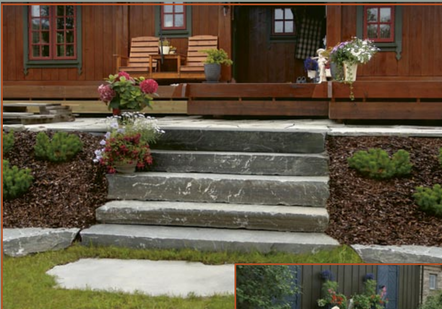
Terrengtrinn og terrasse i Oppdalskifer.
