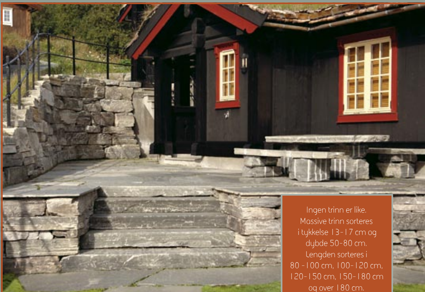
Terrengtrinn, tørrmur 25-45 cm, terrasse i medi bruddheller, bord og benker. Alt i Oppdalskifer.
