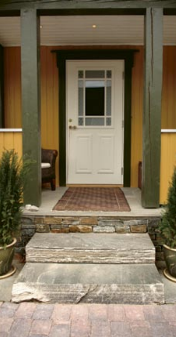
Terrengtrinn i Oppdalskifer med sagede ender og reposhelle.
